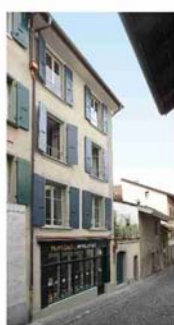
03 – Façade rénovée en 1820 à la rue de l'Horloge avec un commerce au rez
