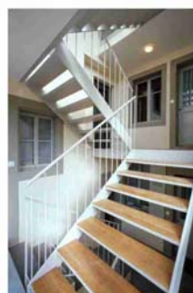
13* – Une cage d'escaliers ainsi qu'un petit ascenseur, installé dans l'ancienne gaine des toilettes, desservent les sept nouveaux logements.
