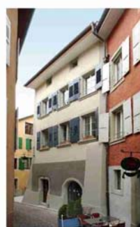
04 – Façade rénovée en 1820 à la rue Verdaine
