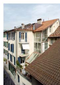
05 – Vue sur l'espace très découpé côté rue de l'Horloge (cage d'escaliers vitrée, v. 13)
