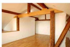
07 – Les aménagements des combles ont permis d'accroître la surface habitable
